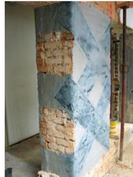
Zid, utrjen s trakovi iz karbonskih vlaken
